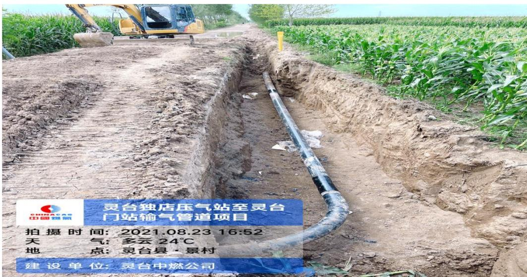
图 4-2 管道施工（景村段）
