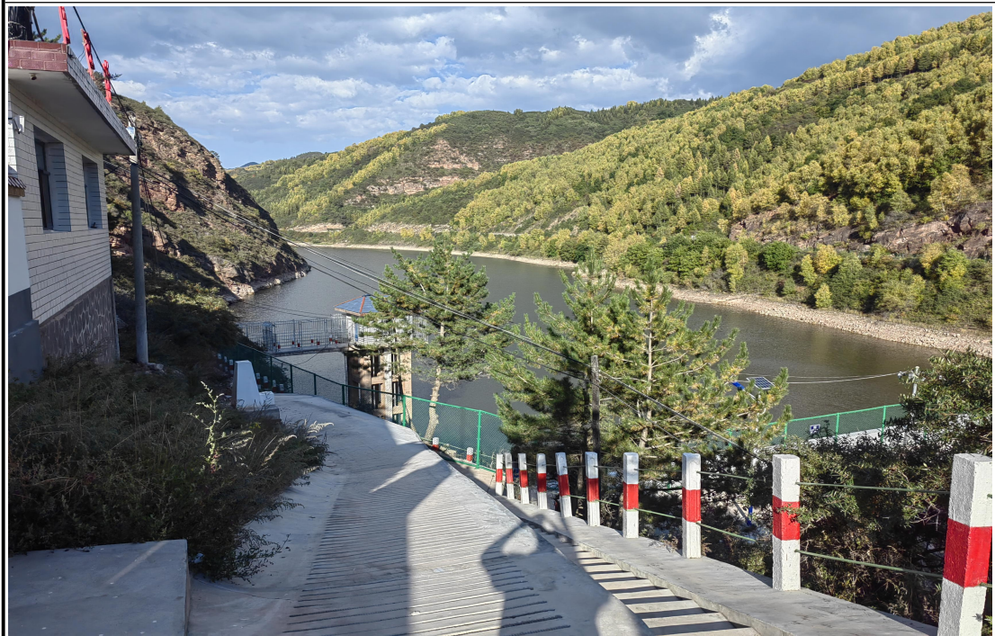
图7-2 基础设施修复图
