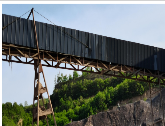
全封闭输送廊道
