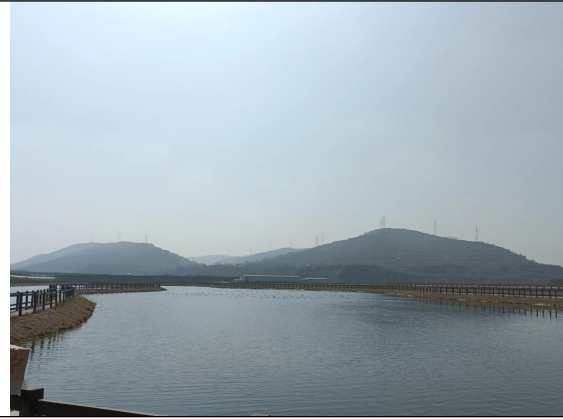
施工后场地情况
