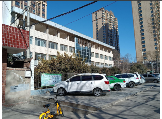
项目东侧（办公楼（正在维修））
