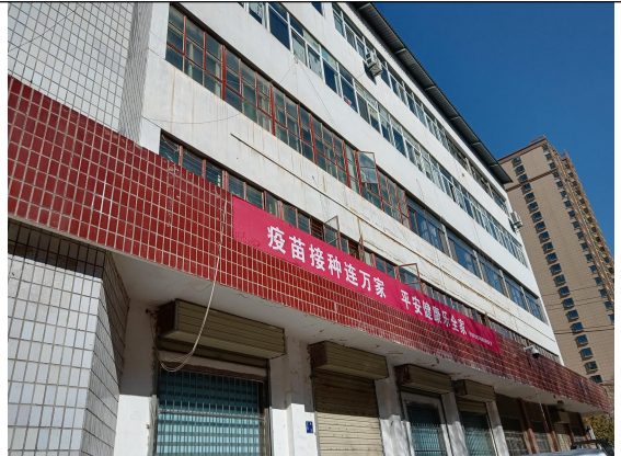
项目所在办公楼（五楼）
