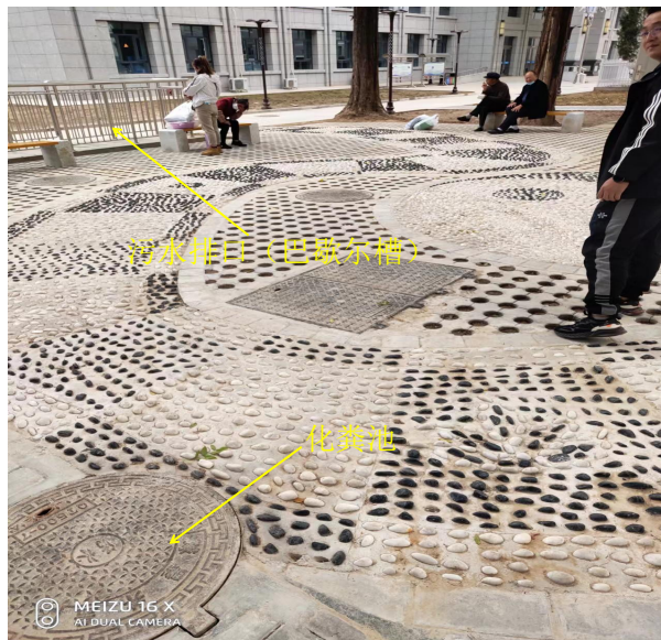
巴歇尔槽、化粪池
