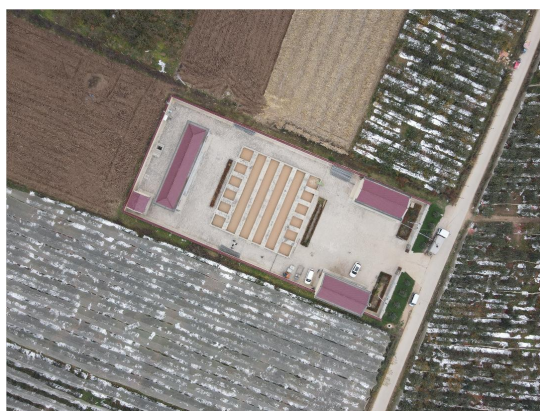
上良乡加压泵站周边恢复情况
