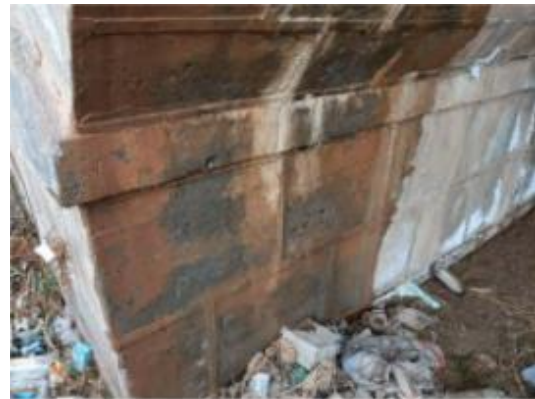
原有桥梁现状照片
