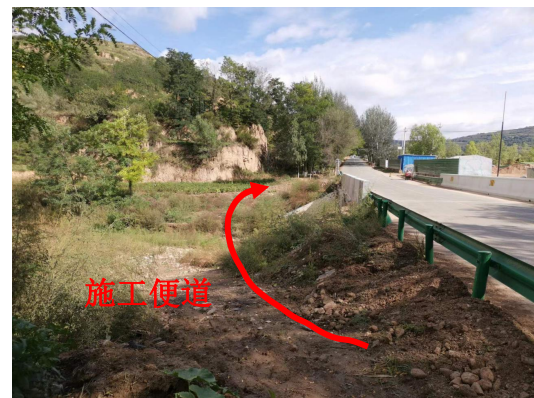
恢复后施工便道现状（生态恢复）
