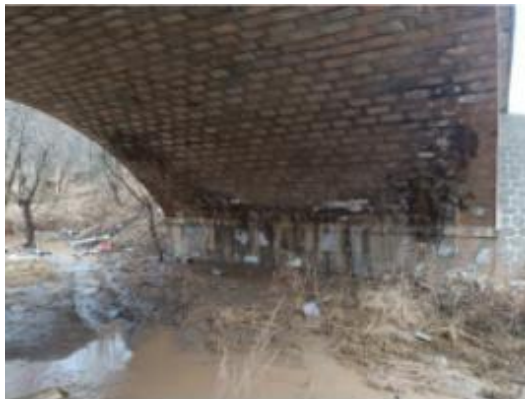
原有桥梁现状照片
