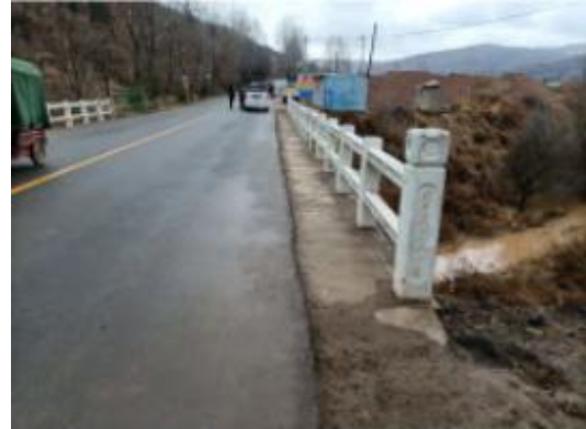
原有桥梁现状照片
