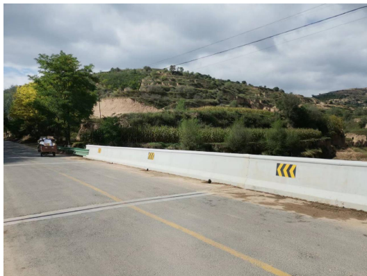
桥面径流收集口
