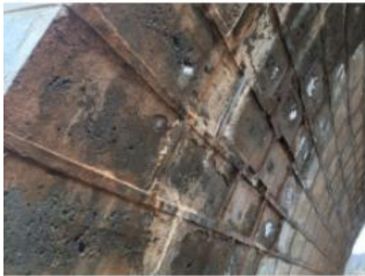
原有桥梁现状照片
