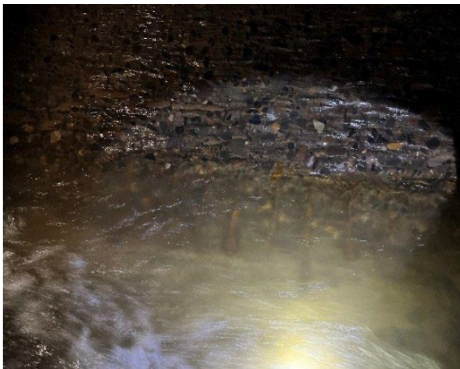
图 3.4-15 现状泄洪洞洞身露筋
