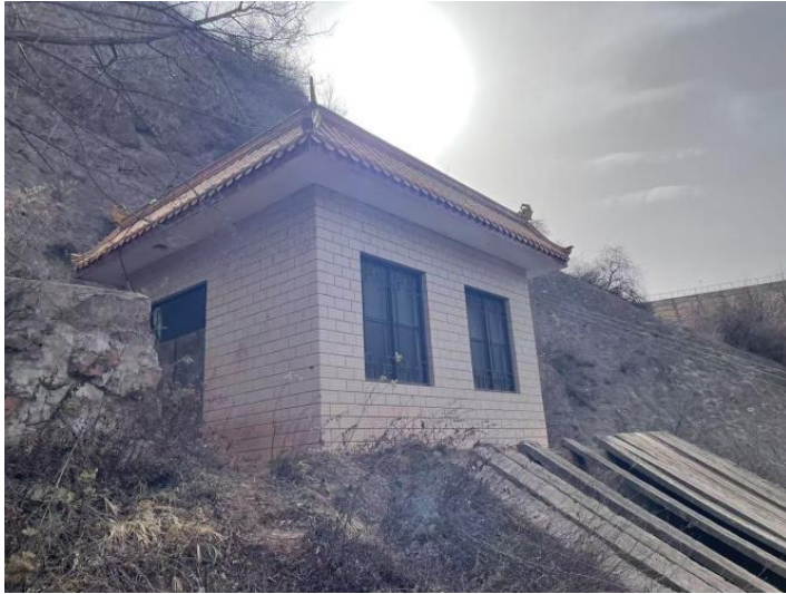
图 3.4-25 输水洞出口闸阀室
