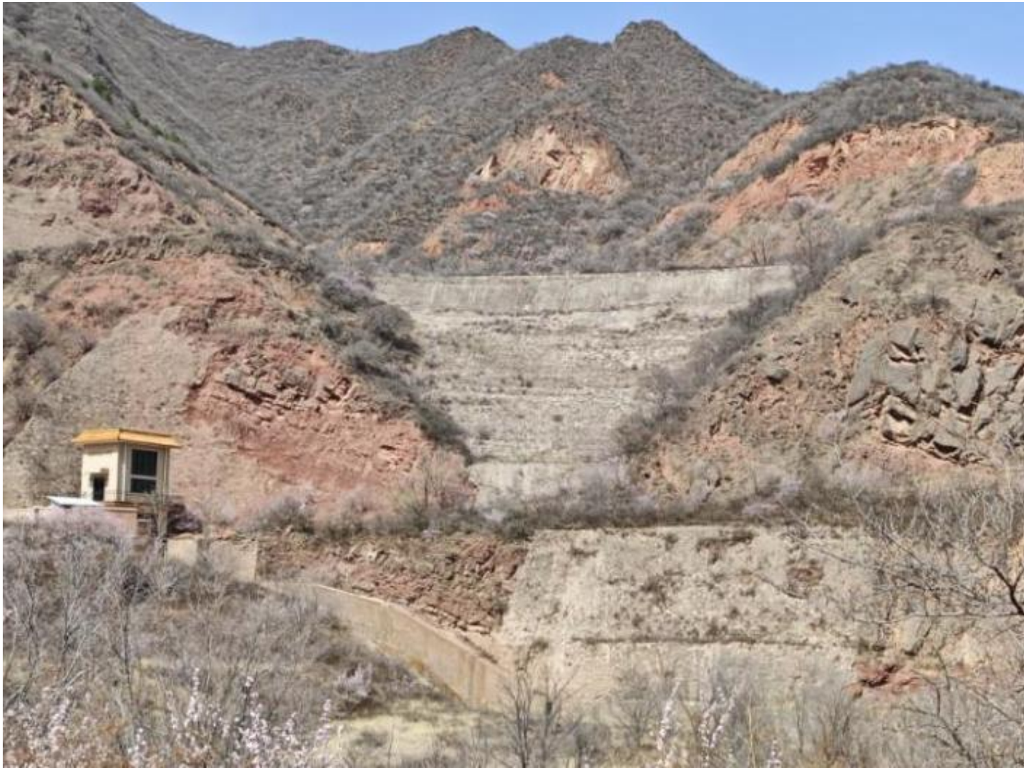
图 3.4-4 溢洪道跨沟填方险段现场照片
