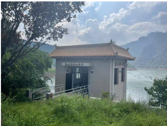
图 3.4-23 输水洞进口闸室
