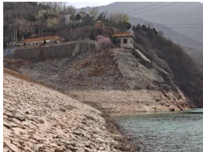
图 3.4-24 输水洞进水塔
