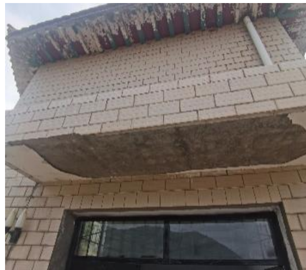
图 3.4-12 进口启闭机房外观
