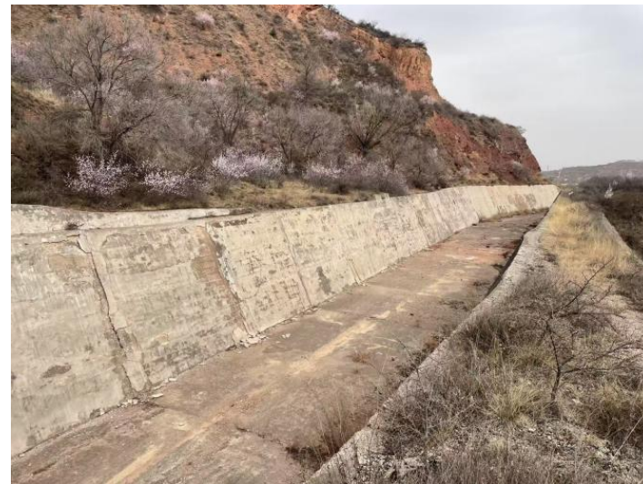
图 3.4-6 溢洪道跨沟填方险段特写
