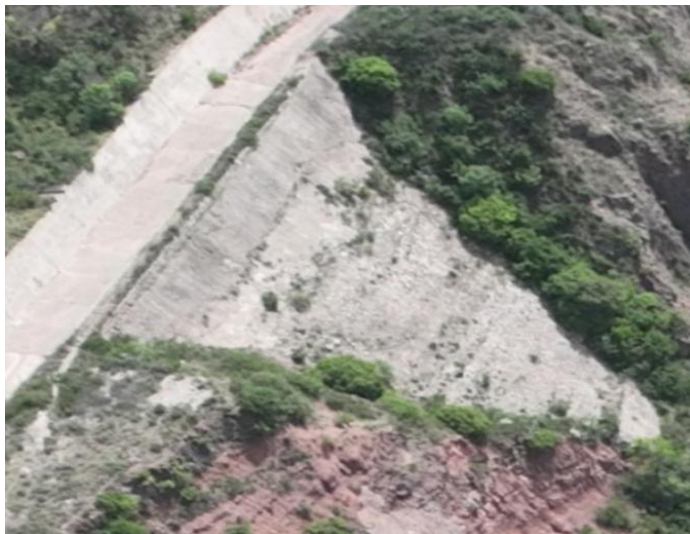
图 3.4-5 溢洪道跨沟填方险段现状
