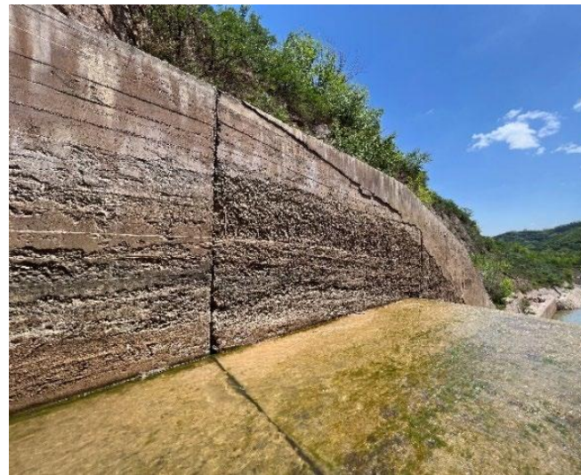
图 3.4-22 渥奇曲线段骨料外露
