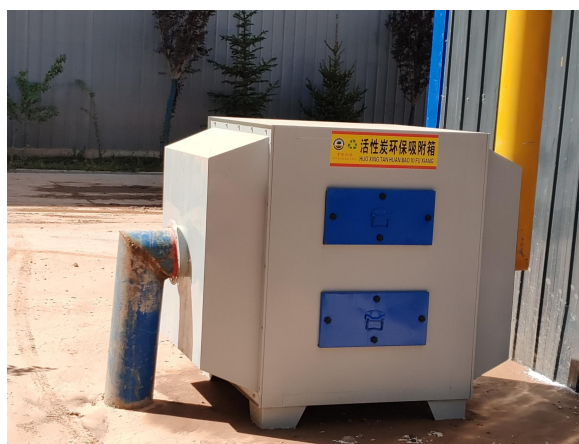
发泡废气吸附装置（活性炭吸附）
