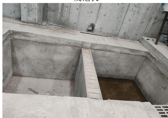
新建 10m³ 二级沉淀池
