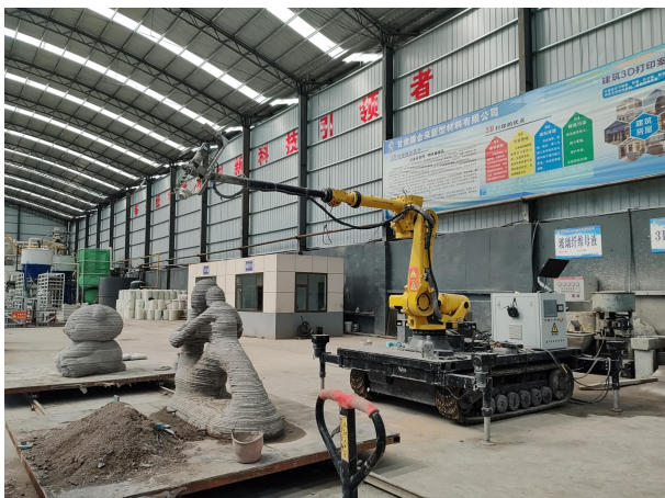
建筑 3D 打印机器人
