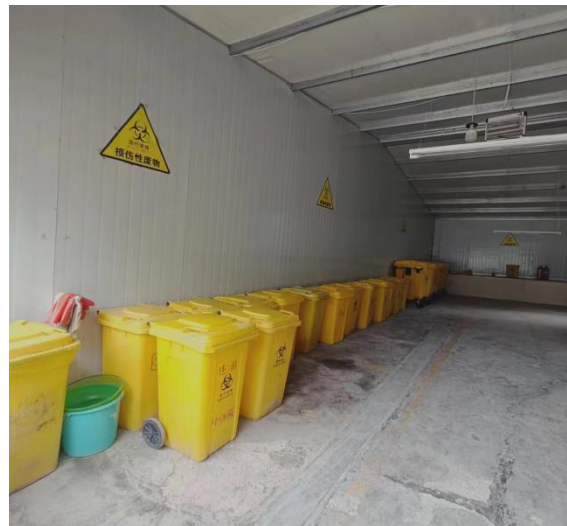
医废暂存间内设
