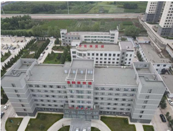
急救医技楼正面俯瞰
