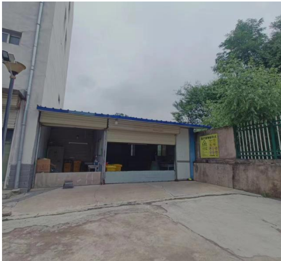
医废暂存间及标识牌
