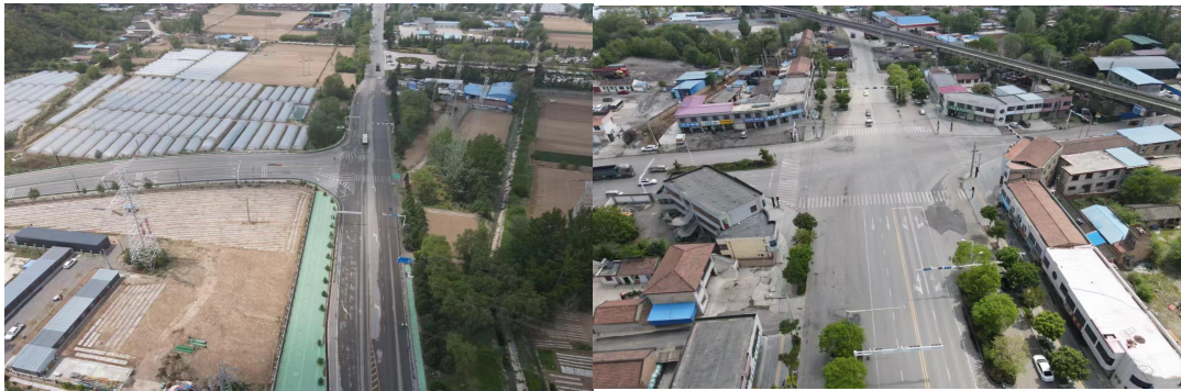
平华一级公路与本项目叉口处（起点）
