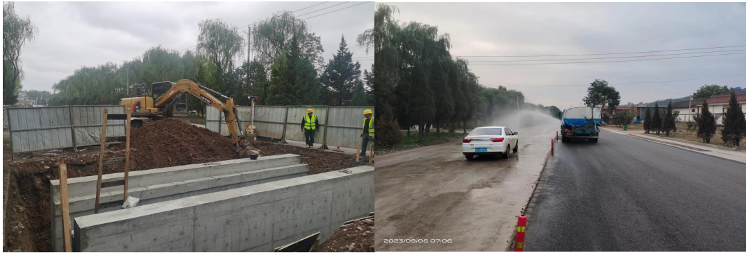
新增涵洞施工（设置围挡）
