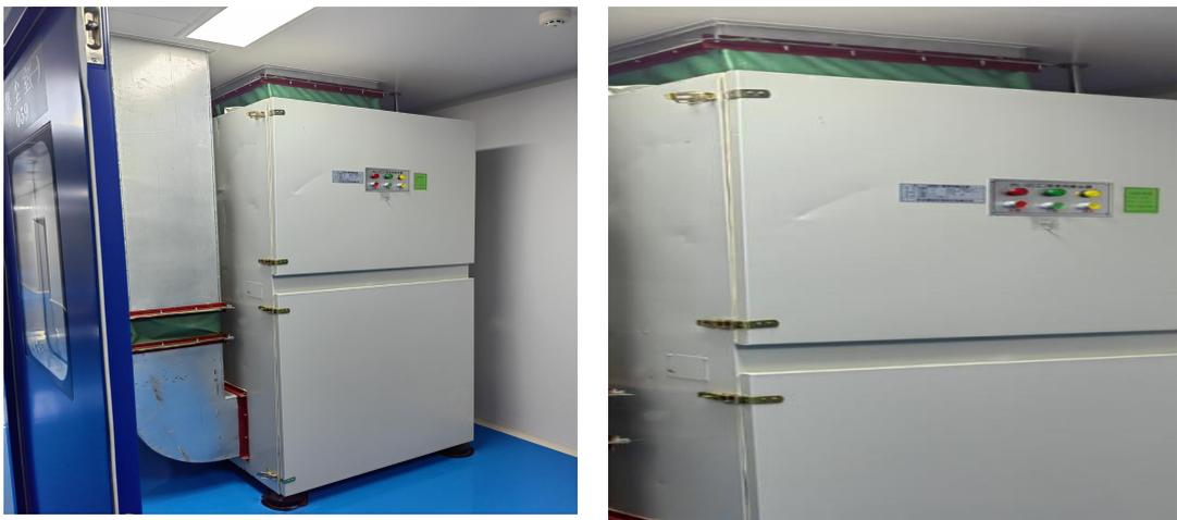
除尘器与屋顶连接处不符合开孔条件
